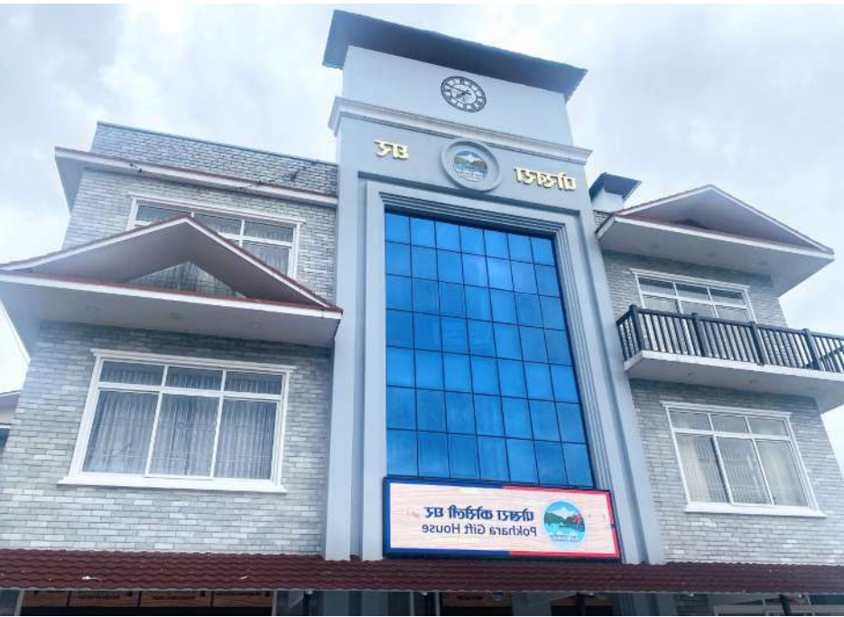
नवनिर्मित ‘पोखरा घर’: कास्कीको पोखरा महानगरपालिका-९ पृथ्वीचोकमा नवनिर्मित ‘पोखरा घर’ । पोखराको पहिचान भल्काउने गरी निर्माण गरिएको यो घरमा पुस्तकालय, कोसेली घर, एकीकृत सूचना केन्द्र र आर्ट ग्यालरी रहने जनाइएको छ । तस्बिर: रामबहादुर थापा/रासस
