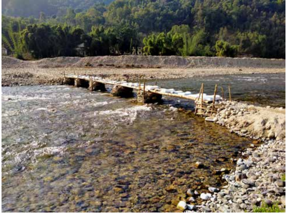
आँधीखोला तर्न बाँसबाट बनाइएको फड्के : स्याङ्जाको भीरकोट नगरपालिका ४ र ५ को बीच सिम्लेमा आँधीखोला तर्नकालागि बाँसबाट बनाइएको फड्के । हिउँदको समयमा स्थानीयहरू फड्केको सहारामा खोला तर्दै आएका छन् । तस्बिर : तोलाकान्त बगाले/रासस
