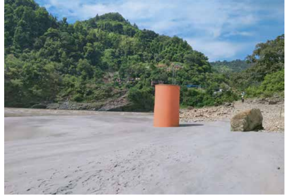
स्याङ्जाको गल्याङ-१ मा अवस्थित रामनदीधाम राम्दीस्थित कालीगण्डकीको किनारमा निर्माण गरिएको ईनार। यही ईनारमार्फत् राम्दी बजारमा पानी तानेर वितरण गरिएको छ। तस्बिर : तोलाकान्त बगाले/रासस
